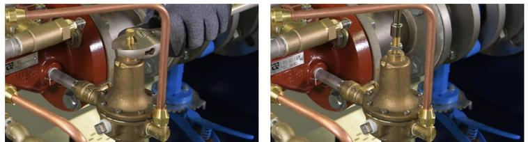
Si su válvula incluye un control de velocidad, afloje la tuerca de bloqueo. Coloque la válvula en la posición completamente cerrada y retrocédala entre 1 vuelta y media y 2 vueltas desde la posición completamente cerrada. El control de velocidad se puede ajustar con precisión una vez que se haya completado el arranque de la válvula.
