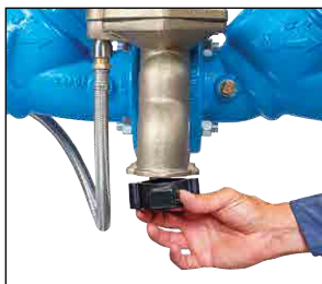
1. Coloque el sensor de inundación en la válvula de alivio.
