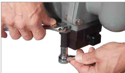
3. Utilice las dos llaves para apretar la tornillería que sujeta el sensor a la válvula.
