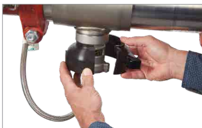
2. Positionnez les deux moitiés du capteur sur la soupape de décharge.
