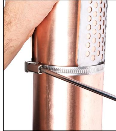
2. Ajuste los tornillos de la lengüeta de la correa para fijar el soporte base en su lugar.
