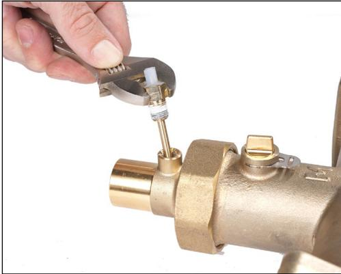
1. Desconecte el cable del sensor, luego desenrosque el sensor de temperatura del conector de salida con la llave Crescent y aparte el sensor. (Para más información, consulte el procedimiento del sensor de temperatura.)
