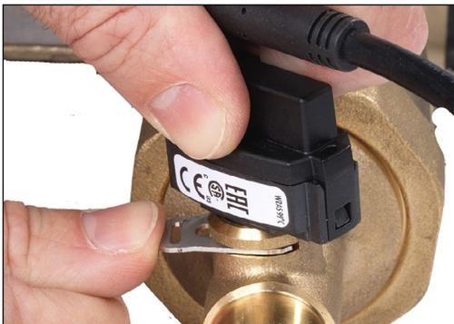
3. Instale el segundo sensor en la entrada de agua caliente (marcada como H) y empuje la abrazadera de retención desde el lado izquierdo. Sienta y escuche el clic que indica que el sensor ha quedado fijado en su lugar. Repita el proceso para instalar el tercer sensor en la entrada de agua fría (marcada como C) y, opcionalmente, el cuarto sensor en la conexión en T de recirculación.
