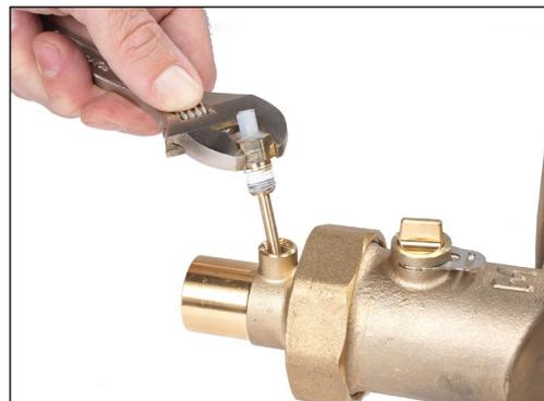
3. Utilisez une clé à molette réglable pour dévisser la sonde de l'orifice.
