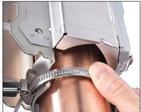
2. Serrer les courroies autour du tuyau, puis fermer les languettes des courroies pour relier la base et les supports supérieurs.
