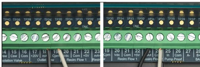
11. Retirez le cache-borne du module de commande et fixez l'autre extrémité du câble d'E/S.
