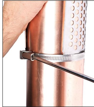
2. Serrer les vis des courroies pour verrouiller le support de base.
