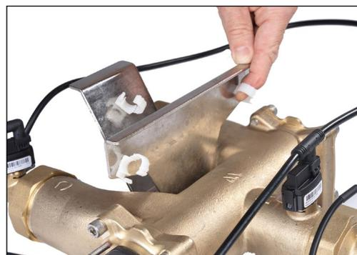
4. Fixez les pinces en plastique au support de montage pour faciliter la gestion et la fixation du câble.
