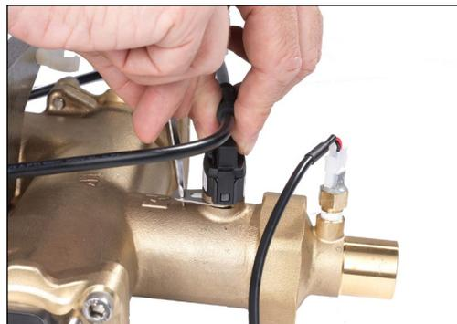
2. Installez la première sonde sur la sortie mixte. Insérez la sonde avec le joint torique dans l'orifice aussi loin que possible. Tout en continuant à presser légèrement la sonde dans l'orifice de la vanne, enfoncez un clip de retenue par le bas pour verrouiller la sonde en place. Sentez et écoutez le clic qui signale une installation appropriée.
