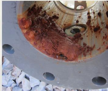
En estas imágenes, tomadas 14 meses después de la instalación, se pueden observar numerosos tubérculos típicos de la corrosión inducida por microbios (MIC) y una corrosión extensa.
