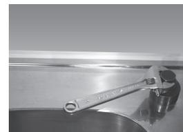
**Étape A** – Percez un trou pilote de 1/4 po. À l'aide d'un perforateur de 1/2 po et d'une clé à molette, percez un trou dans l'évier.
